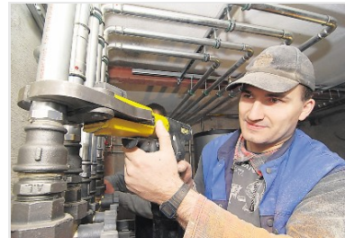
Mario Jähne von einer Bautzner Firma installiert im neuen Kindergarten Hohnstein die Heizungsanlage.
